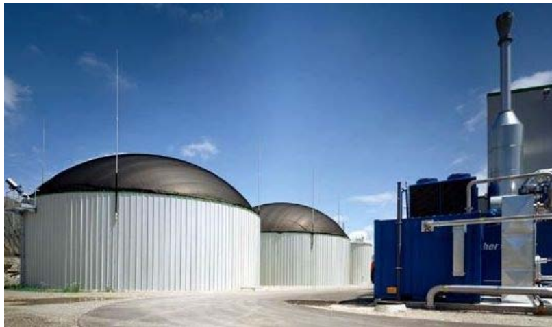
Fig.34 - Impianto di produzione di Biogas / Biometano.
